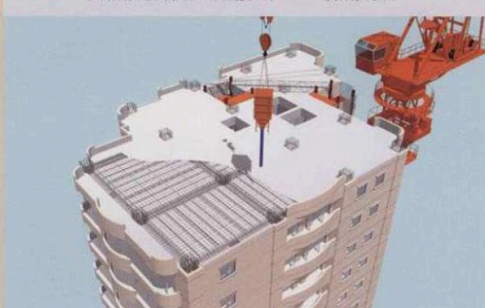
一体化 柱・梁接合部とハーフPCa床板の上にコンクリートを打設し、すべてを一体化します。現場打設量が少なく、確実な施工が行えます。これで1フロア分の構造体が完成。再び次のフロアへと進みます。
