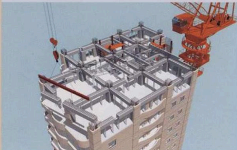
梁 ハーフPCa化された梁を取り付けます。工場より搬入して柱の間に降ろすだけ。小梁も大梁にかけるだけのイメージ・コンストラクションです。取り付け後、PCa梁どうしのジョイント部の下端筋を接合します。
